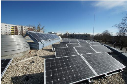
**Projekt:** PV-Aufdachanlage 18,26kW
